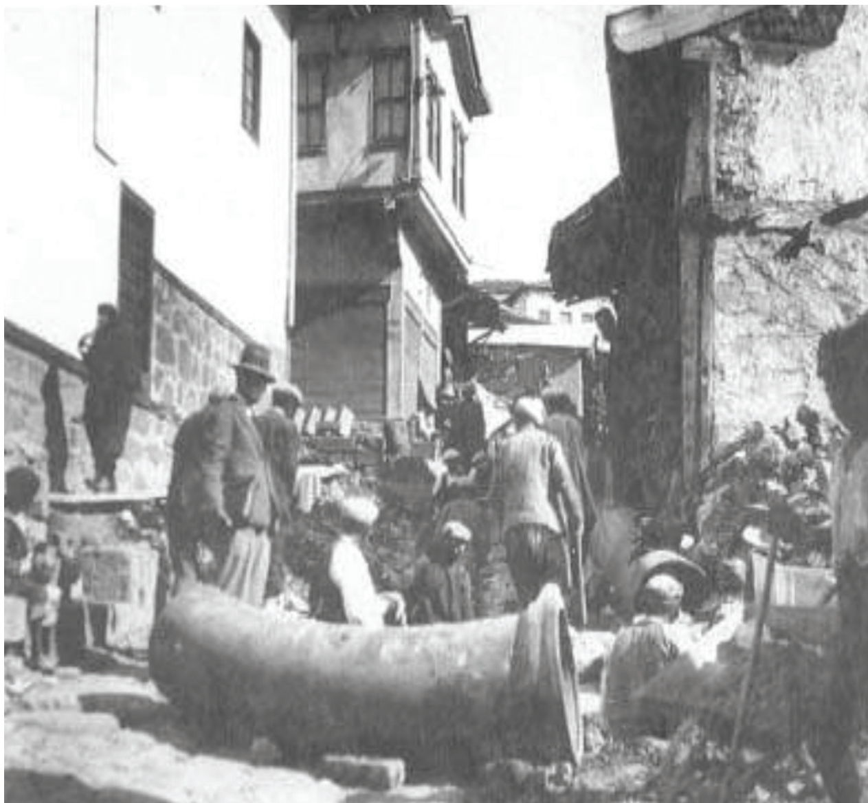
Şekil 3. Kale içinde font borularla su getirme çalışması.
